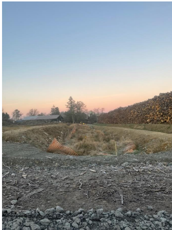
Photo 1 : vue de merlons implantés de part et d'autre de la canalisation
